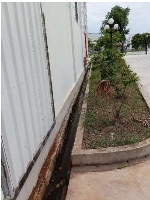
Hình 8. Rãnh thoát nước
