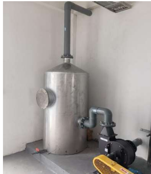
Hình 22. Hình ảnh minh họa tháp hấp phụ bằng than hoạt tính
